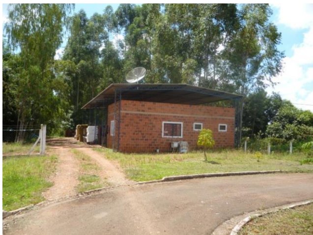
Foto 4.21 - Barracão – Centro de Triagem
