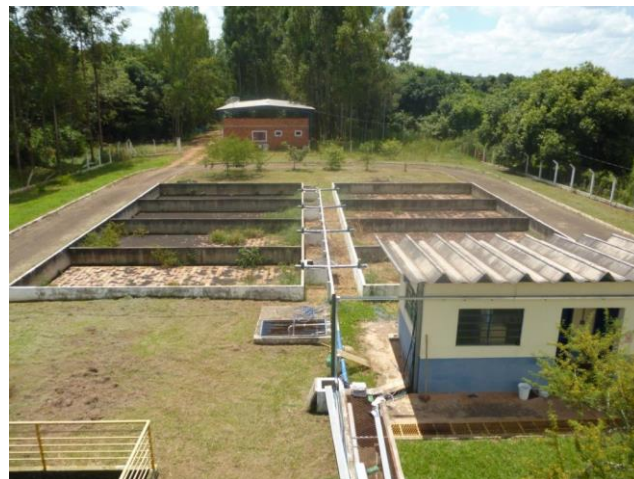
Foto 4.20 - Leitões de Secagem do Lodo
